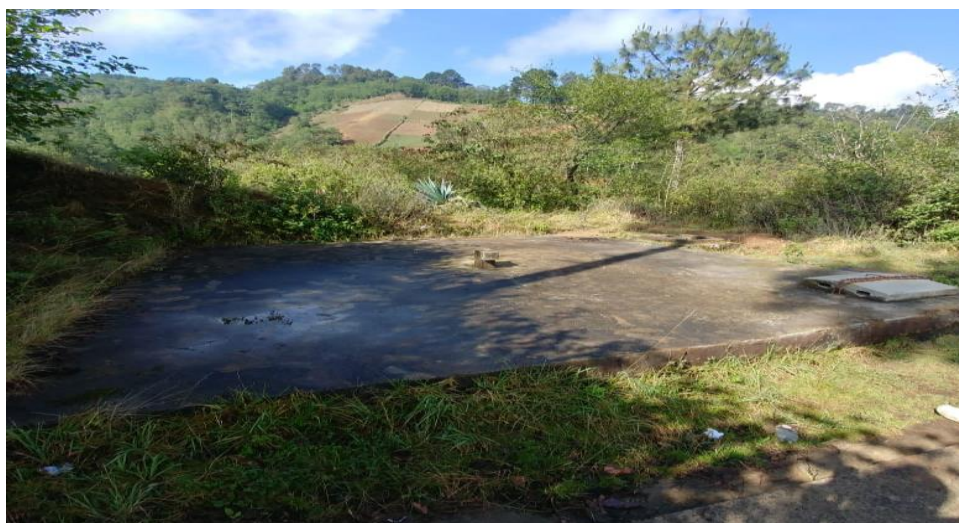
Ilustración 7: Vista del tanque de almacenamiento donde no existe sistema de desinfección
