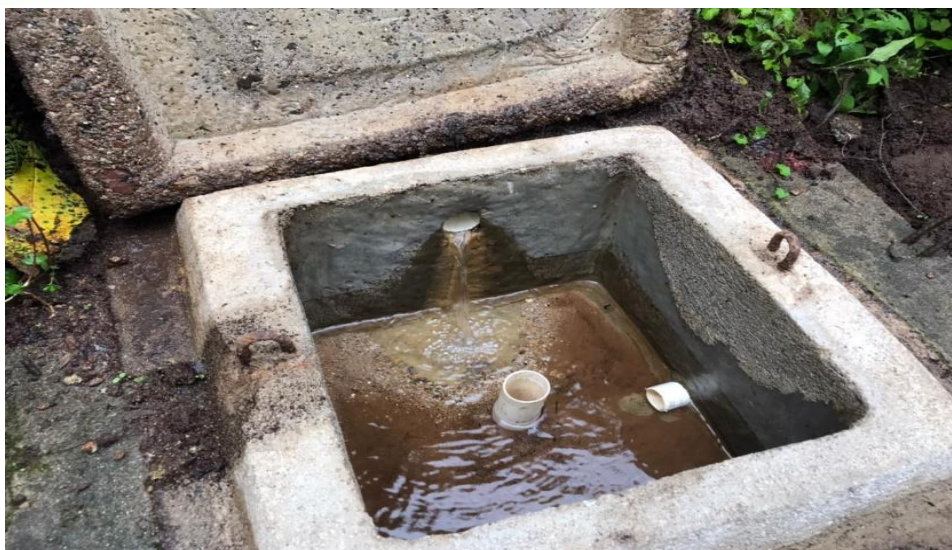
Ilustración 6: Captación de agua de la fuente que abastece a Caserío Chuacorrall, Aldea Pixabaj
