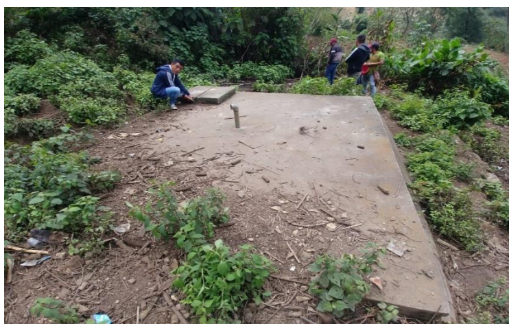
Ilustración 5. Fuente de agua Caserío Churuneles II, Aldea Pujujil II
