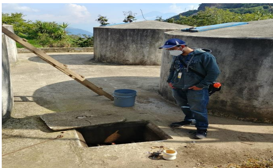
Ilustración 7: Vista del tanque de almacenamiento donde no existe sistema de desinfección
