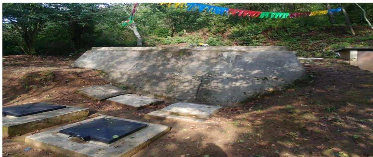
Ilustración 7. Vista del tanque de almacenamiento donde no existe sistema de desinfección
