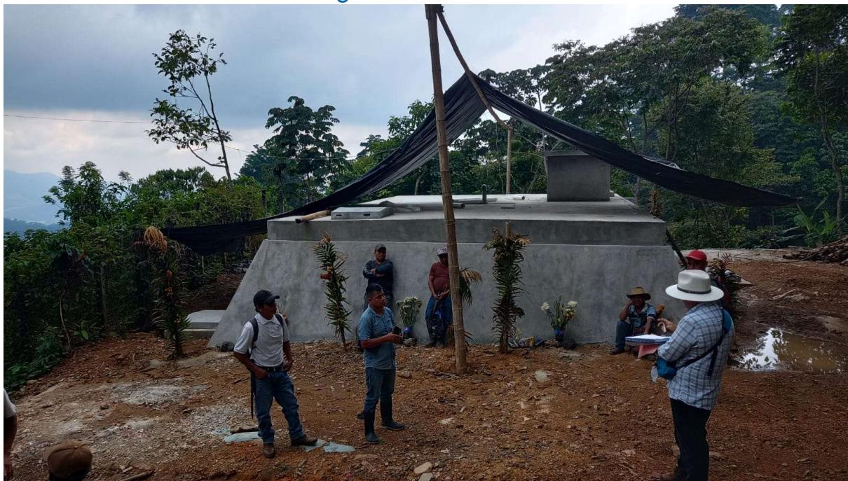
Fotografía No. 1 Tanque de distribución en construcción
