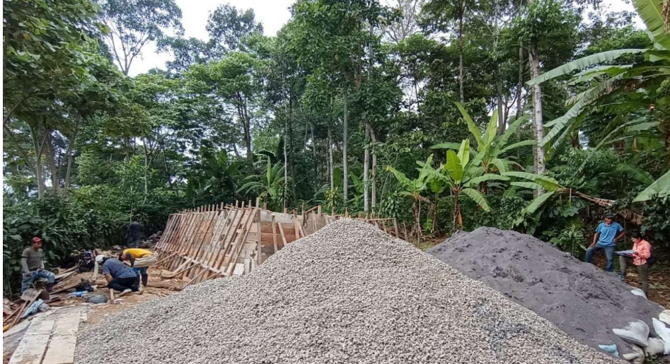
Fotografía No. 1 Tanque de distribución en construcción
