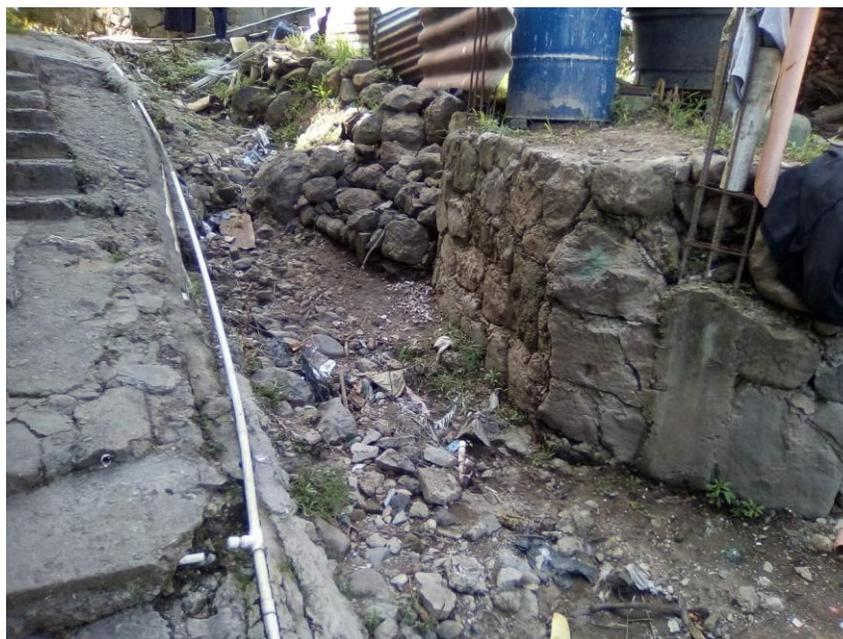
*Ilustración 3: Fotografía de tubería PVC expuesta de red de Distribución.
