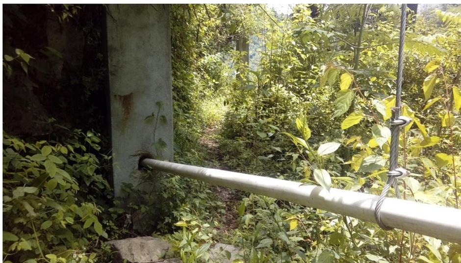
*Ilustración 2: Paso Aéreo con tubería de PVC.
