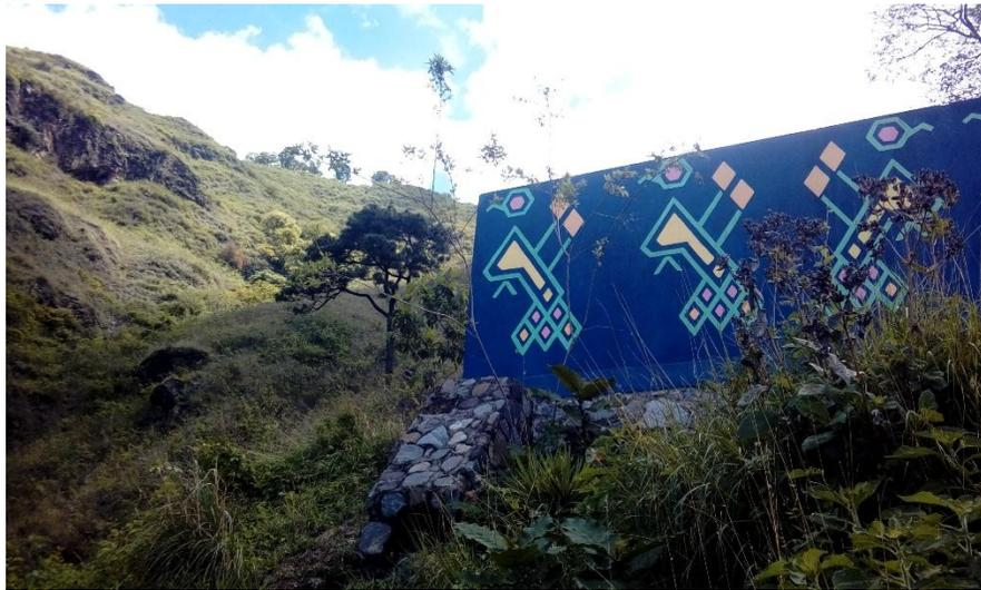
Ilustración 4: Tanque de Distribución Vista Hermosa, con carencia de circulación perimetral, escalones exteriores, cuneta para desfogue de agua de lluvia, roca con probabilidad de desprendimiento hacia parte baja del casco urbano del municipio.
