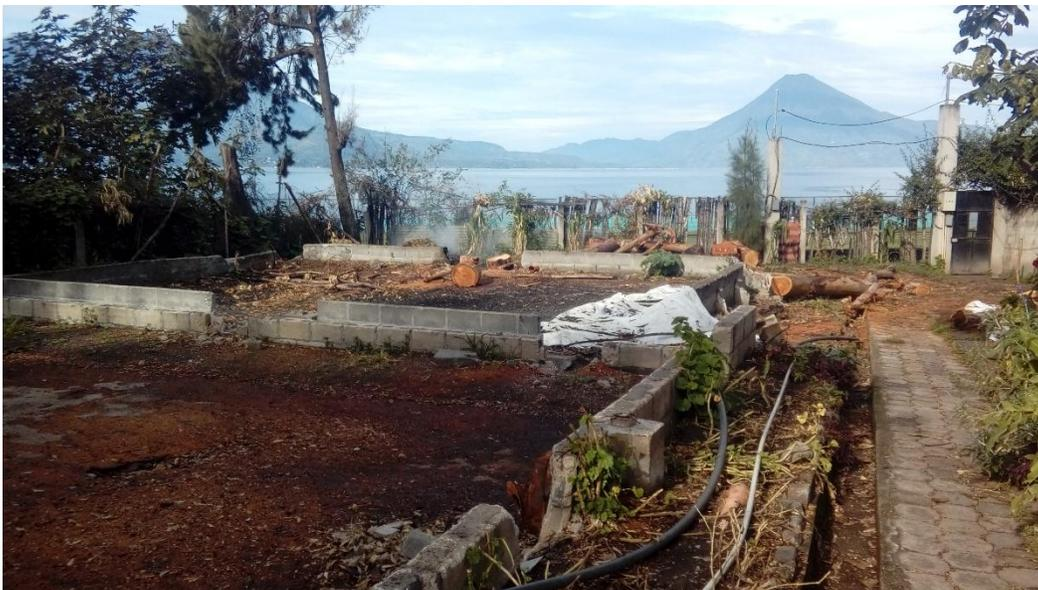
*Ilustración 5: Patios de secado de lodos Planta de Tratamiento de Aguas Residuales Santa Catarina Palóp sin funcionar, techo destruido por la caída de árboles y carente de filtro*
