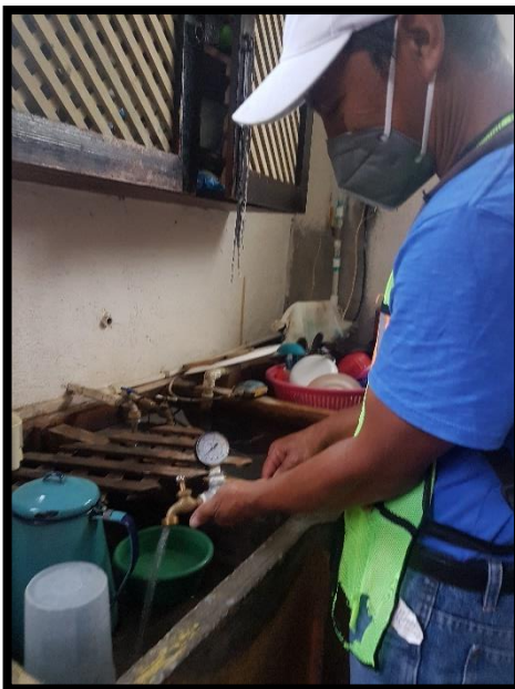
Ilustración 11. Medición de presión de servicio
