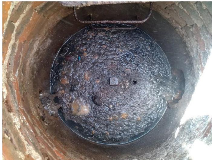
En la fotografía 24 se ve un pozo con presencia de materia fecal y lodos azolvada, esta situación da lugar futuros atascos en la tubería, lo que propiciaría afloramiento de las aguas residuales creando focos infecciosos.
