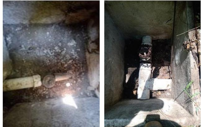
Válvula de aire y de compuerta, línea de conducción de la fuente Xolmanzán
