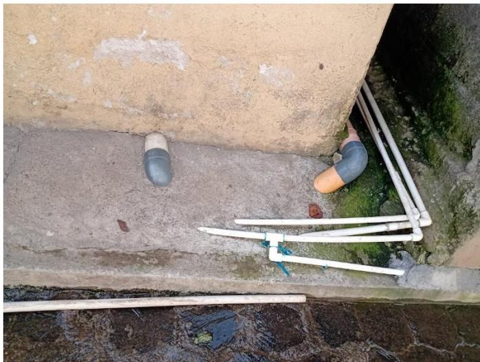
En la fotografía 19 se evidencia una válvula con fugas lo cual afecta la distribución del sector suministrado, disminuyendo la presión de llegada creando intermitencia en el servicio, además las válvulas que no poseen caja fotografía 20 tienden a quedarse azolvadas lo que dificulta el mantenimiento y al dañarse pueden inducir la contaminación en parte de la red.
