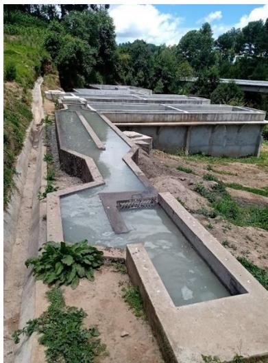
En la fotografía 26 se puede evidenciar que la planta de tratamiento no cuenta con cerco perimetral, adicionado a esto las cajas de operación no poseen candados. La planta de tratamiento carece de bodega, estación de limpieza para el uso de los operarios.
