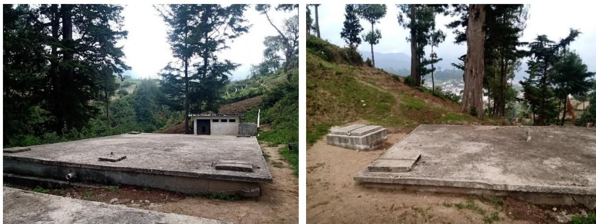
Los dos tanques conectados en serie poseen un clorador de pastillas cada uno lo que hace difícil el cálculo de la concentración de cloro esto se evidencia en las viviendas donde la dosis no cumple los parámetros mínimos de 0.5 mg/L como lo establece la Norma COGUANOR NTG 29001.
