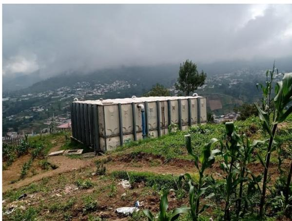
En la caja rompepresión de la línea de distribución se encuentra una tubería de la línea de conducción que se conecta directamente a la caja sin pasar por el sistema de desinfección lo que modifica la concentración de cloro suministrada a los usuarios, como se evidencia en la fotografía 22.
