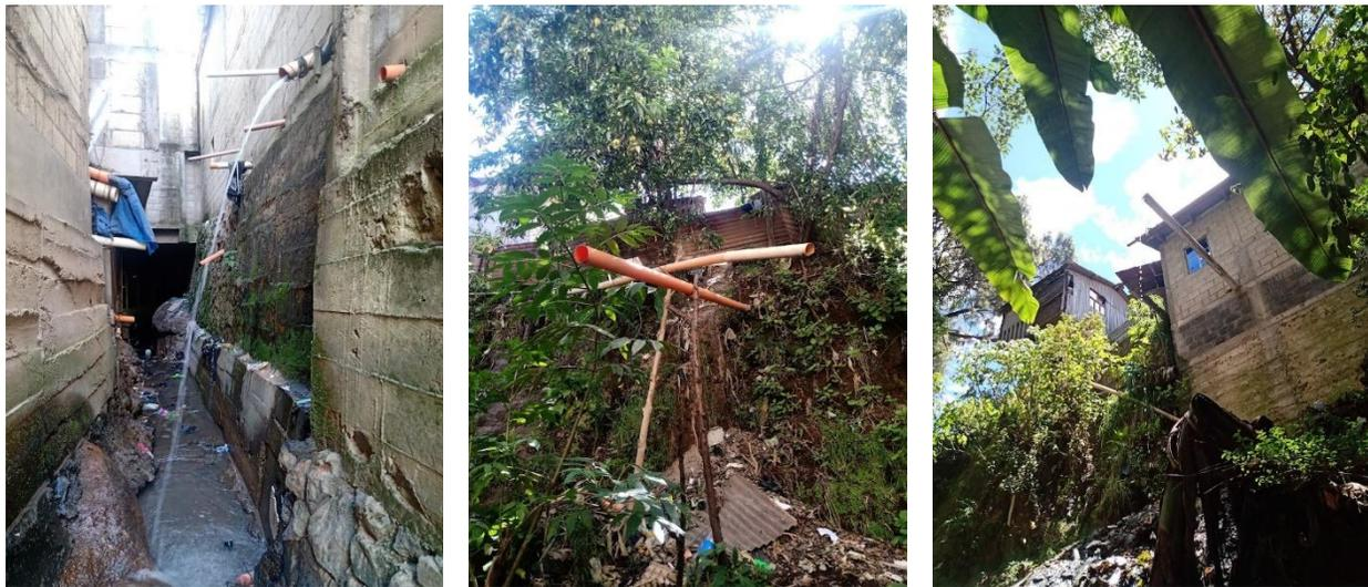
Entre las descargas se pudo evidenciar la descarga de Chuisuc una comunidad que está al otro lado del zanjón en donde se presume que también estén conectadas algunas casas de la zona 2 en la fotografía 4 se puede observar esta descarga que al no contar con un dissipador o cabezal de descarga tiende a caer de forma abrupta hacia el zanjón. En la misma serie de fotografías se puede observar a la izquierda la acumulación de grasas las cuales confirman la descarga de aguas grises y negras.
