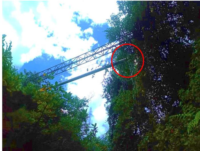
En la fotografía 25 se puede evidenciar una tubería de 8 "que presenta ruptura, esta tubería conduce el agua de uno de los sectores de la zona 2, este desfogue por ruptura propicia la creación de un foco infeccioso muy importante teniendo en cuenta la importancia de la tubería.
