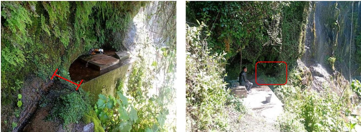
En la fotografías anteriores se puede evidenciar que la estructura de captación de la fuente Xolmanzán se encuentra sobre una roca representando peligro de caída para los operadores, debido a que el paso a la fuente es estrecho, y por la humedad y materia vegetal presente es arriesgado el pazo hacia la fuente, por la ubicación de la fuente es complicado circularla por lo que la seguridad de la misma depende de las tapaderas de ingreso.
