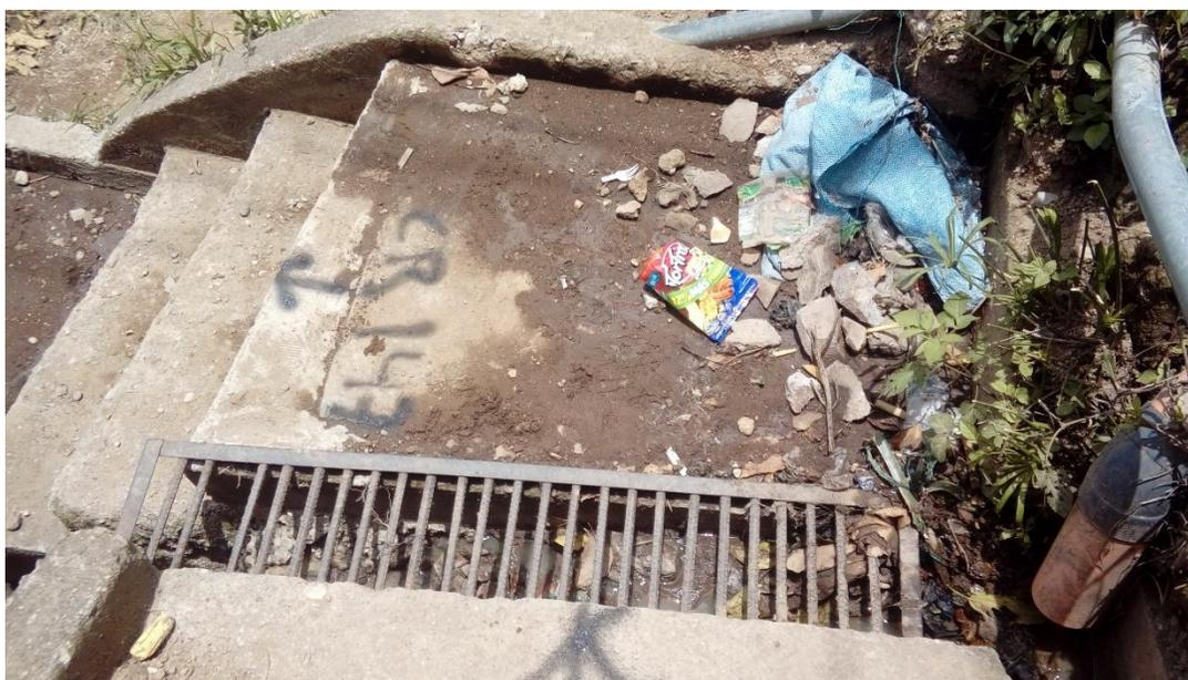
*Ilustración 8: Vista de caja de registro cubierta de lodo y basura.
