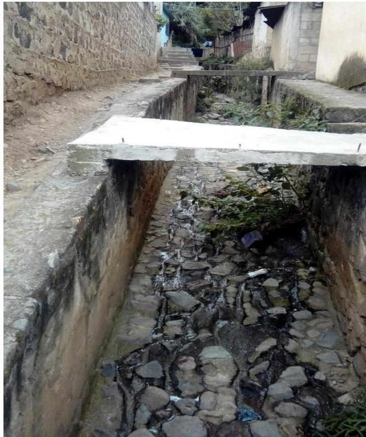
*Ilustración 7: Vista de canal para desfogue de aguas pluviales, falta limpieza, rehabilitación y produce malos olores*
