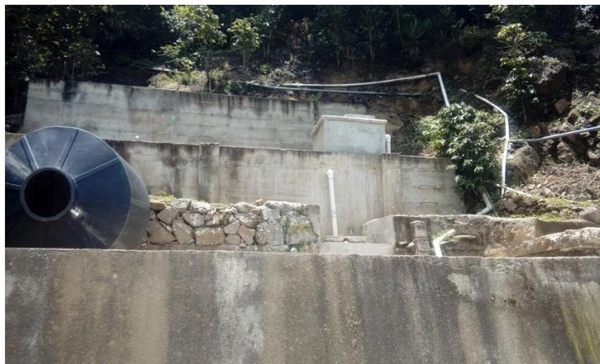
*Ilustración 4: Vista del tanque de distribución sistema Caliaj, con tubería PVC de línea de conducción expuesta a intemperie y sin circulación del área.
