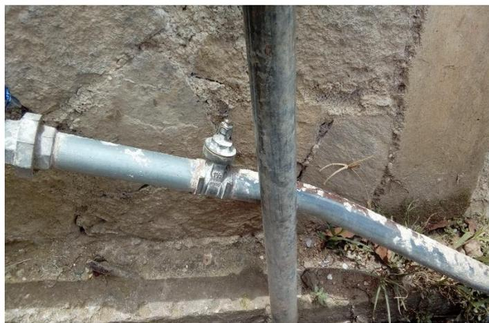
Ilustración 6: Vista de válvula para línea de distribución sin funcionamiento
