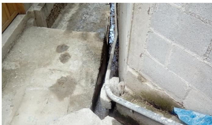
Ilustración 5: Vista de tubería HG de línea de distribución sin accesorios y expuesta a cuneta de aguas grises
