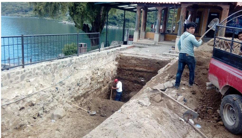
*Ilustración 10: Vista de excavación para tanque de bombeo de Planta de Tratamiento de Aguas Residuales
