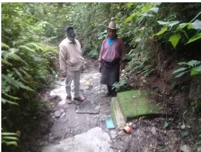
Ilustración 1: Vista del sistema de captación Caliaj, Tecpán Chimaltenango, falta limpieza de tapaderas y circulación de área
