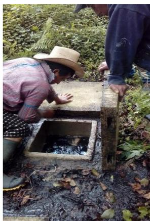
Ilustración 1: Vista del sistema de captación Panimaché 2, Chichicastenango, el Quiché, falta limpieza del área interna y externa
