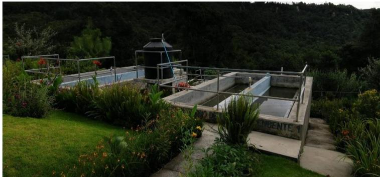
Ilustración 8. Reactores Anaerobios de Flujo Ascendente
