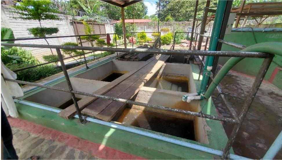
*Fotografía 40 Digestores de la planta de tratamiento*
