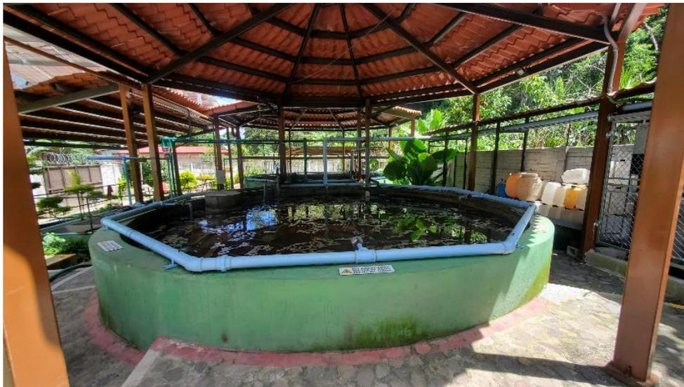
Fotografía 39 Digestores de la planta de tratamiento
