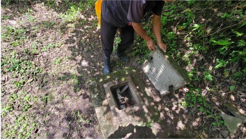
Fotografía 13 Válvula de limpieza en línea de conducción.
