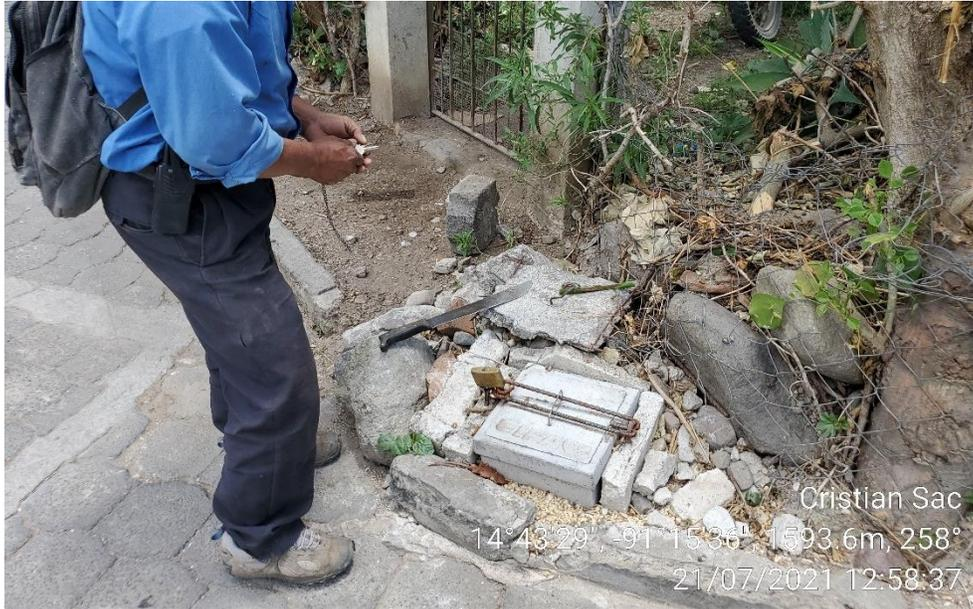
Fotografía 30 Cajas de válvulas de operación red de distribución
