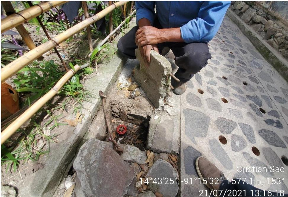
Fotografía 32 Cajas de válvulas de operación red de distribución 3
