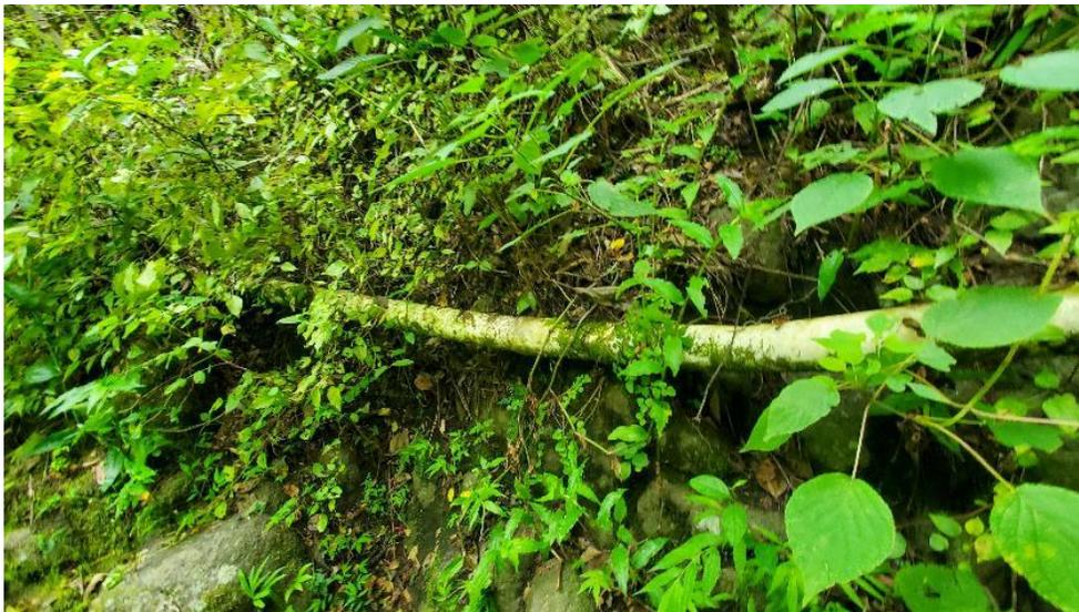
Fotografía 16 Tubería expuesta en conducción
