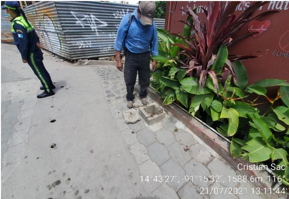
Fotografía 31 Cajas de válvulas de operación red de distribución 2
