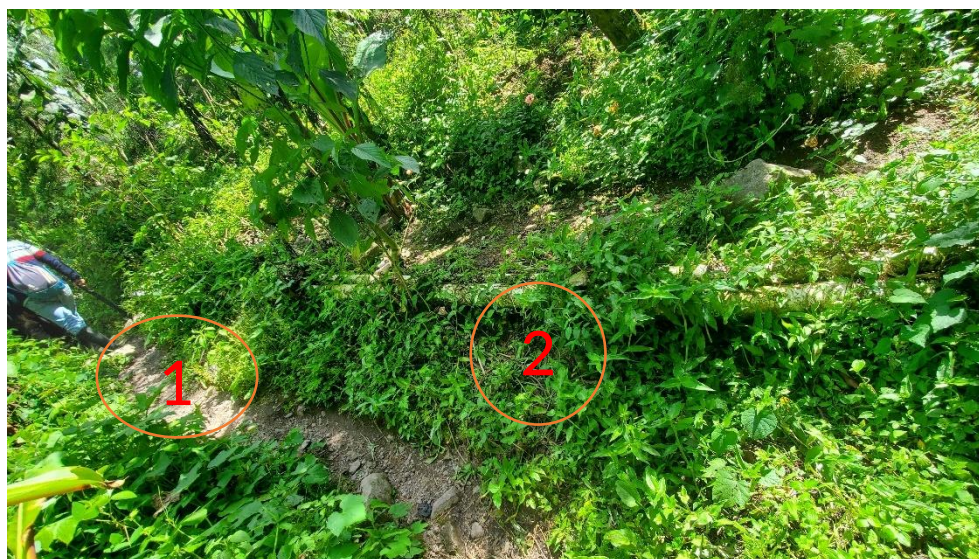
Fotografía 9 Línea de conducción
