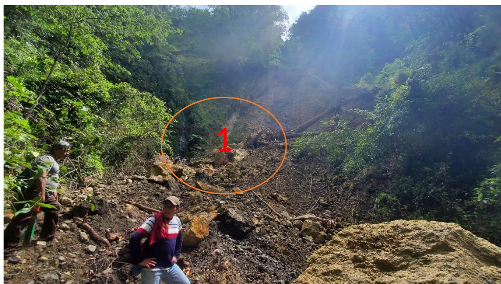
Fotografía 1 Deslizamiento cercano a fuente Hocico de Mono 1
