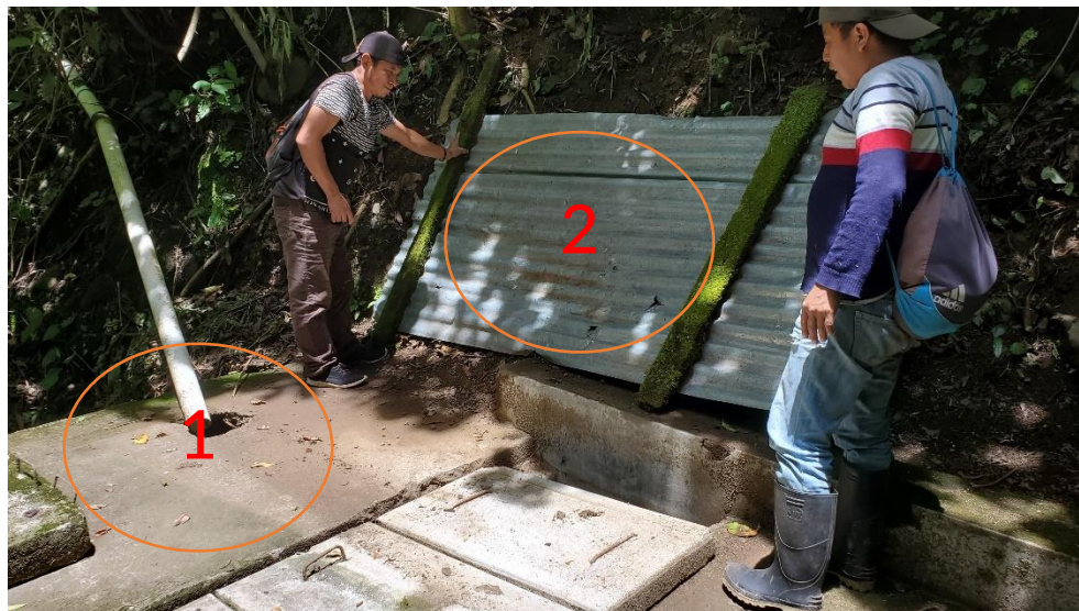
Fotografía 4 Filtro de grava para captación Hocico de Mono 1
