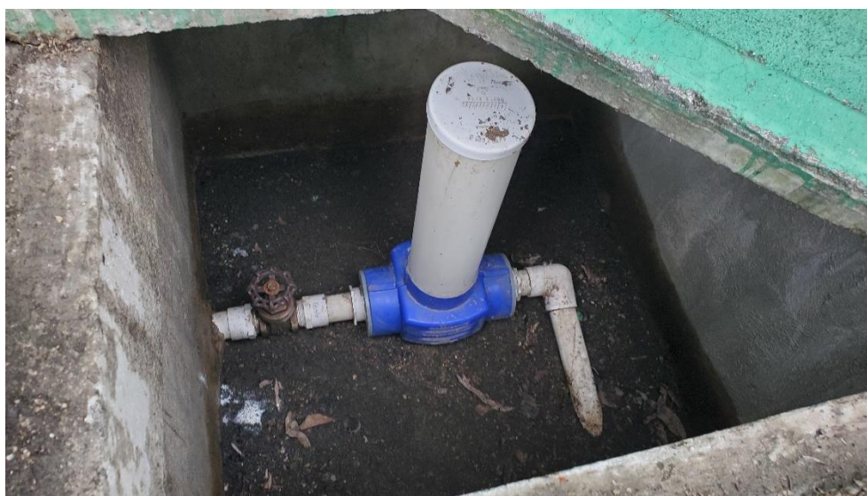
Fotografía 11 Sistema de desinfección tanque de almacenamiento Xepajp
