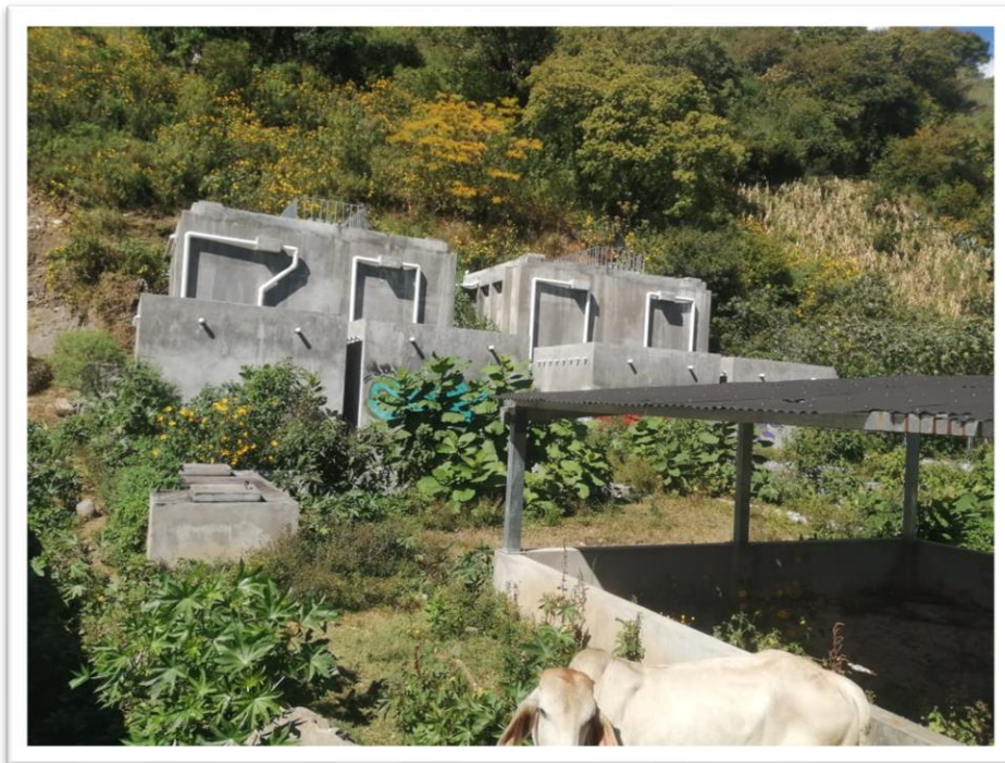
Fotografía 25 Planta de tratamiento de aguas residuales, sin funcionamiento 3
