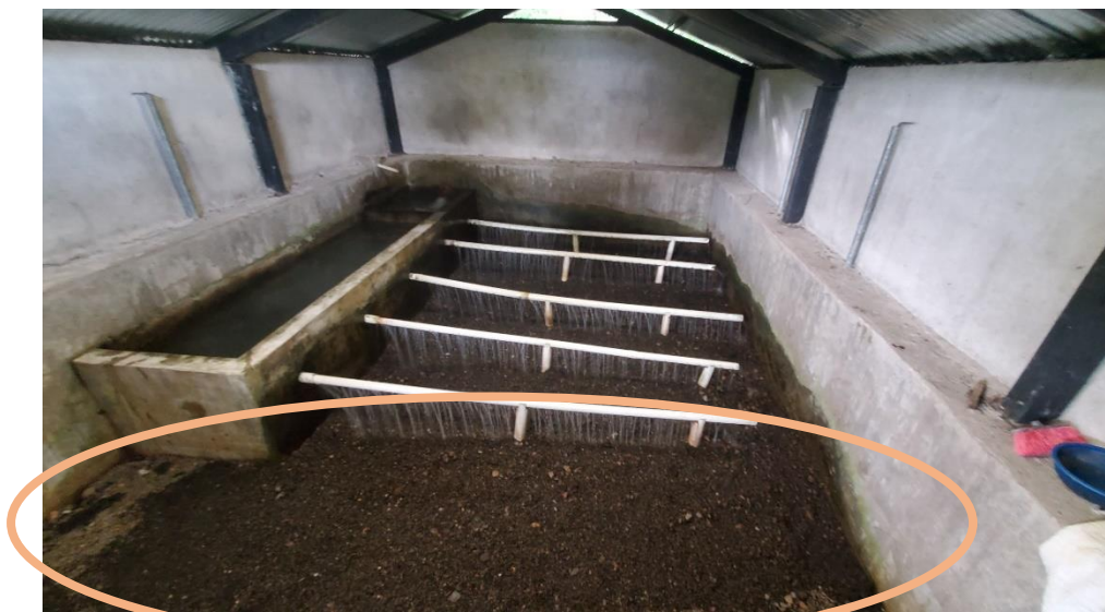
Fotografía 13 Canal de ingreso y tubería de distribución de agua en filtro
