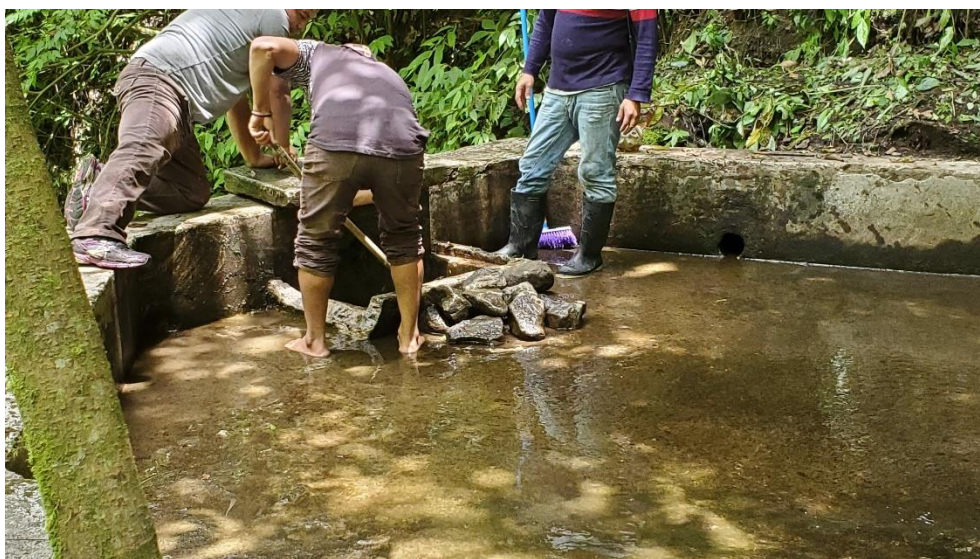
Fotografía 7 Captación Pak'ib 1, limpieza de estructura.
