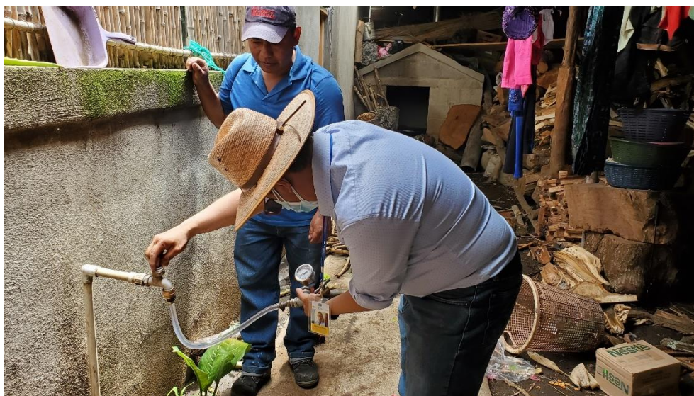
Fotografía 31. Medición de presión en viviendas.
