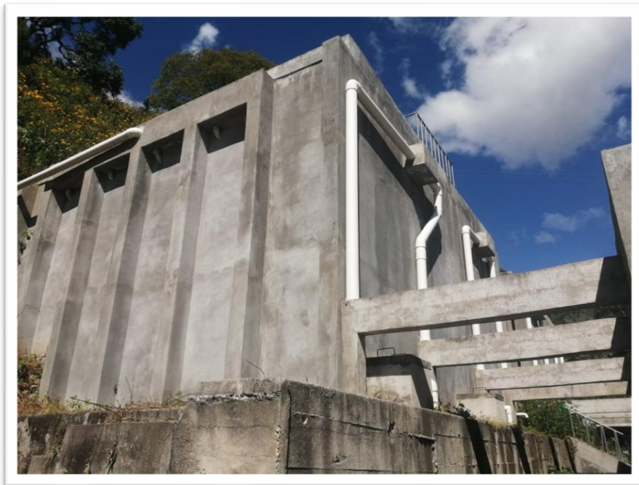
Fotografía 23 Planta de tratamiento de aguas residuales, sin funcionamiento 1
