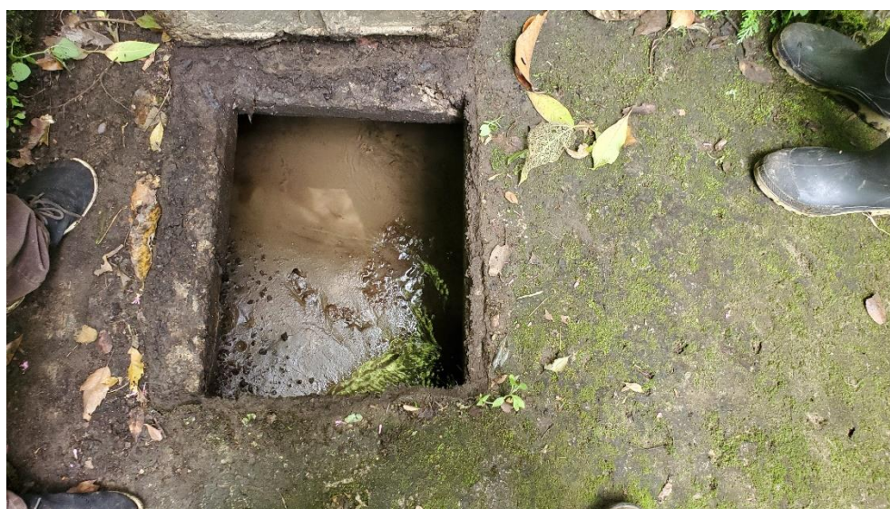
Fotografía 3 Nacimiento Hocico de Mono 1, sedimentos en caja de captación.
