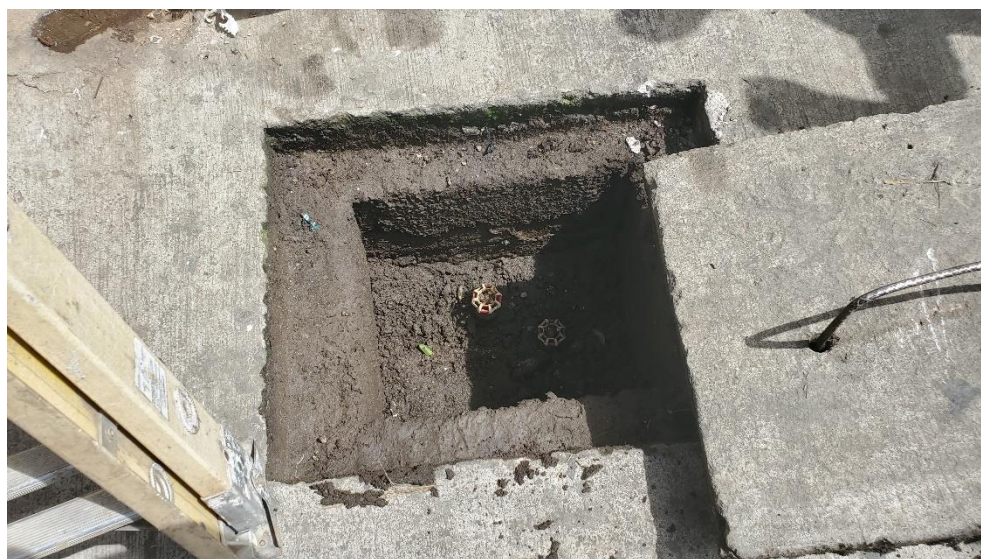
Fotografía 16 Cajas de válvulas de operación red de distribución
