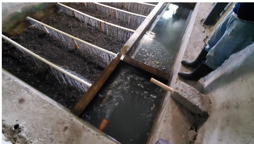
Fotografía 14 Canal de ingreso
