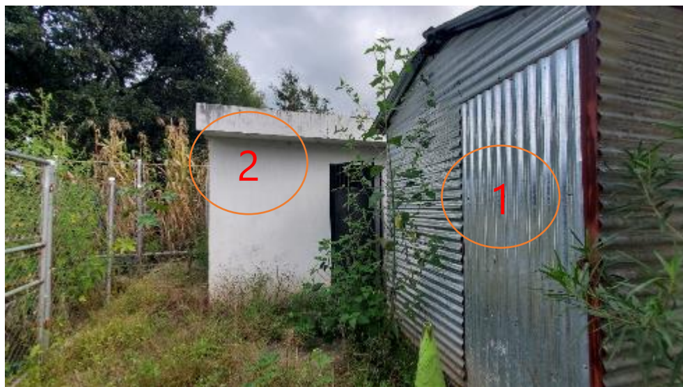
Fotografía 17 Protección elementos pozo mecánico "Pasaqman"
