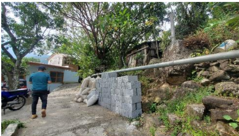
Fotografía 21 Línea de conducción
