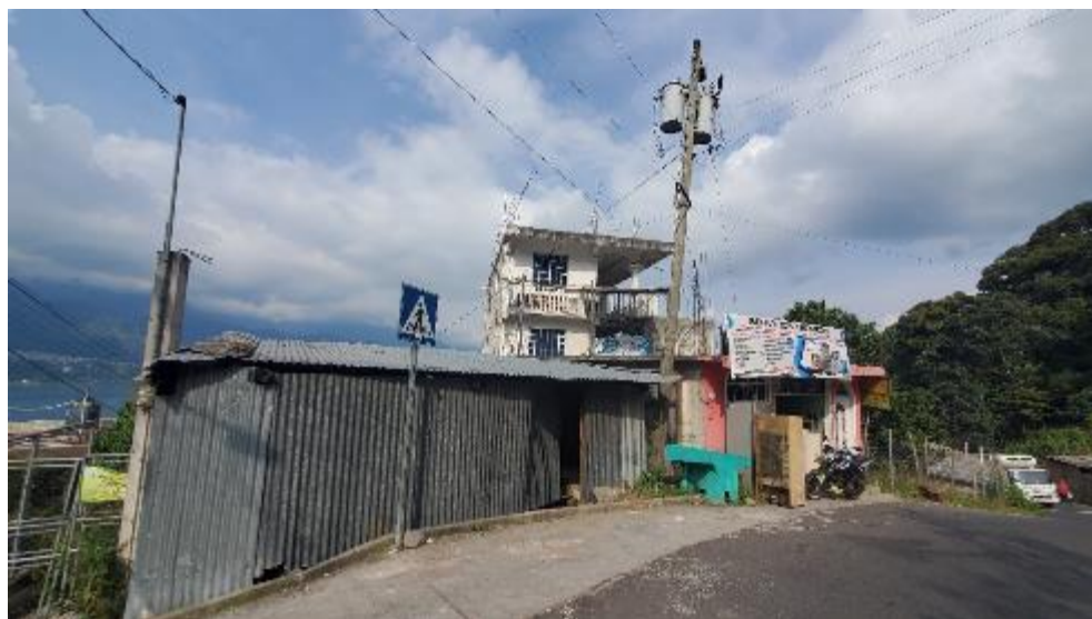
Fotografía 29 Tanque de distribución
