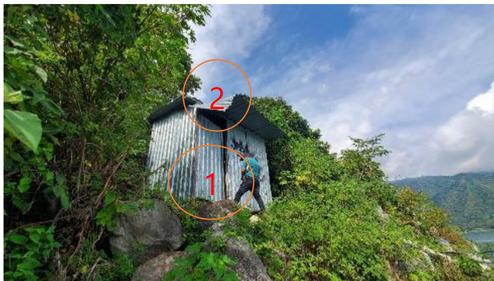
Fotografía 7 Caseta de control "Orilla del Lago"
