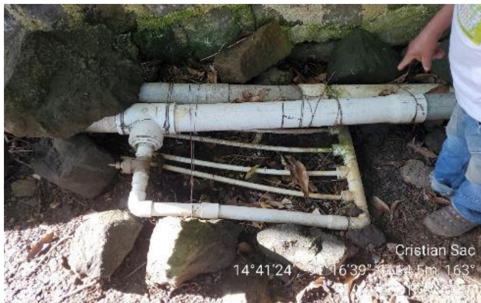
Fotografía 40 Conexiones domiciliarias realizadas antes del tanque de distribución
