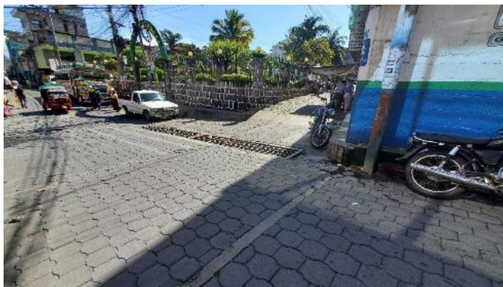
Fotografía 49 Rejillas para sistema de drenaje Pluvial calzada principal
