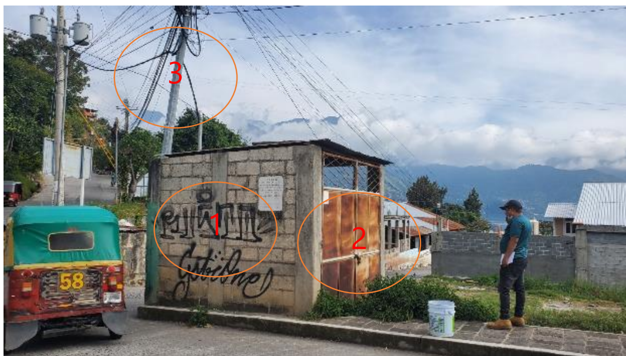
Fotografía 2 Caseta del pozo Mecánico “La Calzada”
