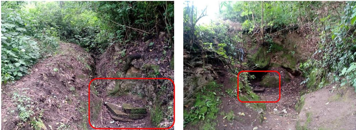
En las fotografías anteriores se puede evidenciar que las unidades se encuentran enterradas, por lo que ante un evento de derrumbes o trasporte de suelo aluvial podrían quedar soterradas y con ello dificultar su acceso y mantenimiento.
