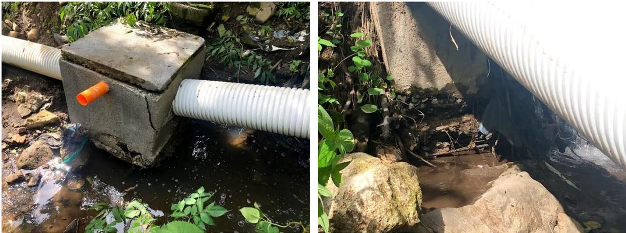
En las fotografías 17 y 18 se evidencia que las cajas conectoras del proyecto del nuevo colector se encuentran agrietadas y socavadas, dicho colector no transporta aguas residuales porque no se han conectado las casas al no estar completo el tramo por la que la tubería se encuentra parcialmente instalada.
