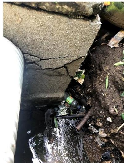
Fotografía 18. Cajas conectoras presencia de erosión en su base
