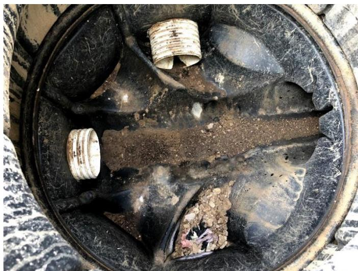
El barrio la parroquia parte del sector 4, posee su sistema de alcantarillado, el cual está conformado por tubería PVC, de 8" y 4" y desfoga hacia el zanjón. Posee pozos de visita de 1 metro de profundidad, los pozos de visita no presentan azolvamientos, no se evidencia la construcción de media caña, pero el desnivel que posee hace que el agua fluya hacia el otro extremo del pozo, sin embargo, no se evidencia gran cantidad de material azolvado.
