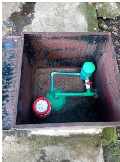
Actualmente el clorador instalado en el tanque de Los Baños se encuentra inhabilitado, el agua proviene clorada de la red de distribución del sistema de Intervida la cual pasa arriba del tanque Los Baños. En la fotografía a la izquierda se evidencia el sistema de cloración del sistema de Intervida y a la derecha el clorador artesanal del tanque Los Baños. Al no tener sistema de
