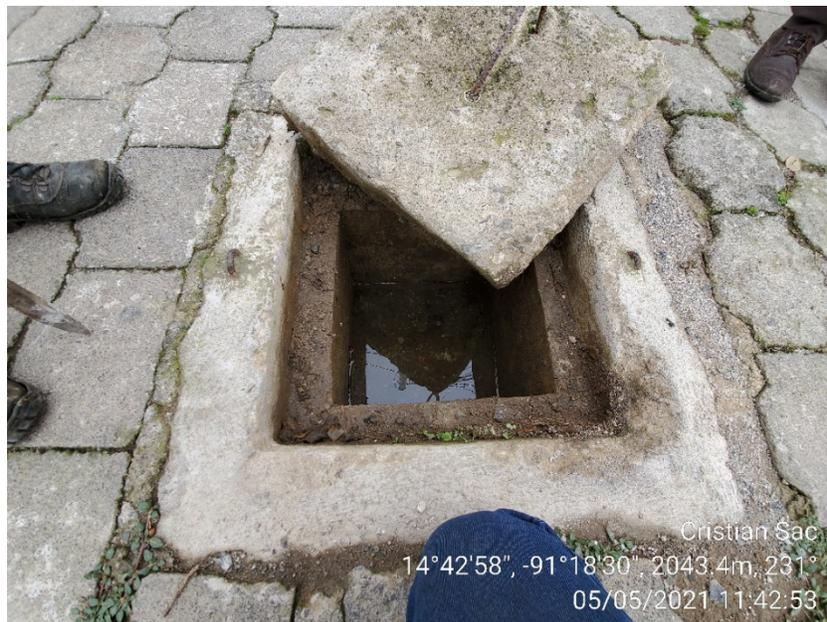
*Fotografía 6 Cajas de válvulas de operación red de distribución*
