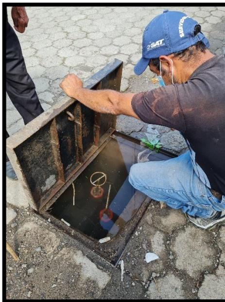
Ilustración 10. Fuga en una de las válvulas de la red de distribución
