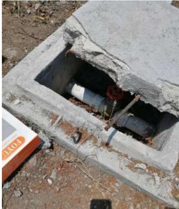
Fotografía 23. Tapadera de caja de válvulas
