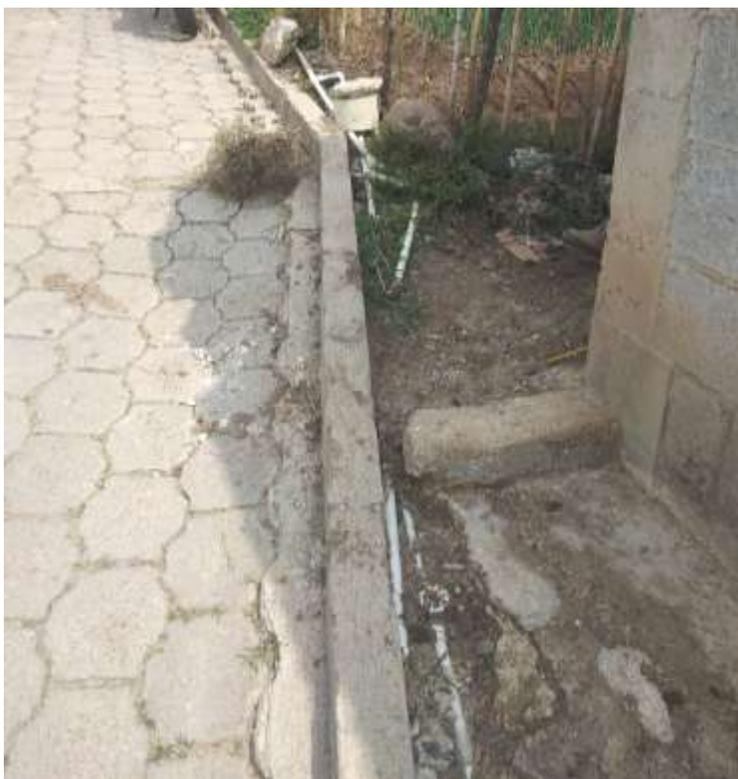
Fotografía 11. Tubería expuesta en red de distribución
