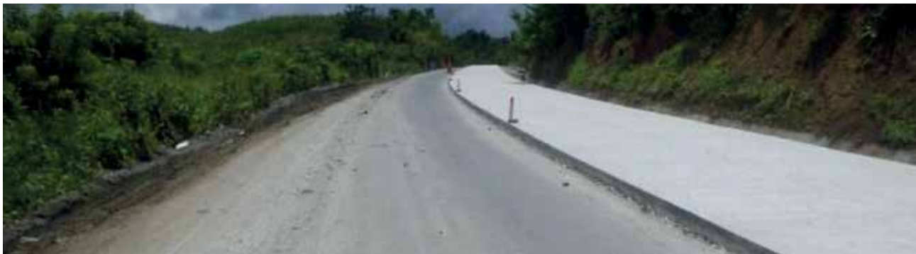
Fotografía 2. Carretera 7-E, tramo en construcción
